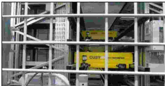
Uno dei Robot del nuovo magazzino della Camozzi
